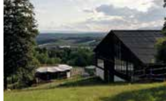
Halle und Schrittmaschine
